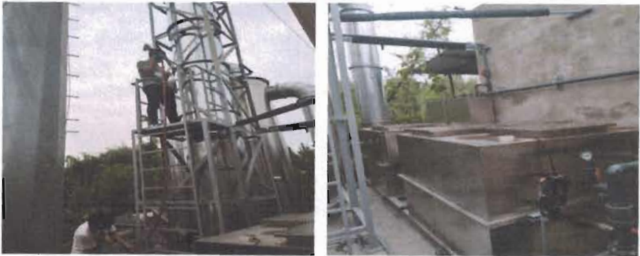
图 4.1-4 抛光废气处置及排气筒
